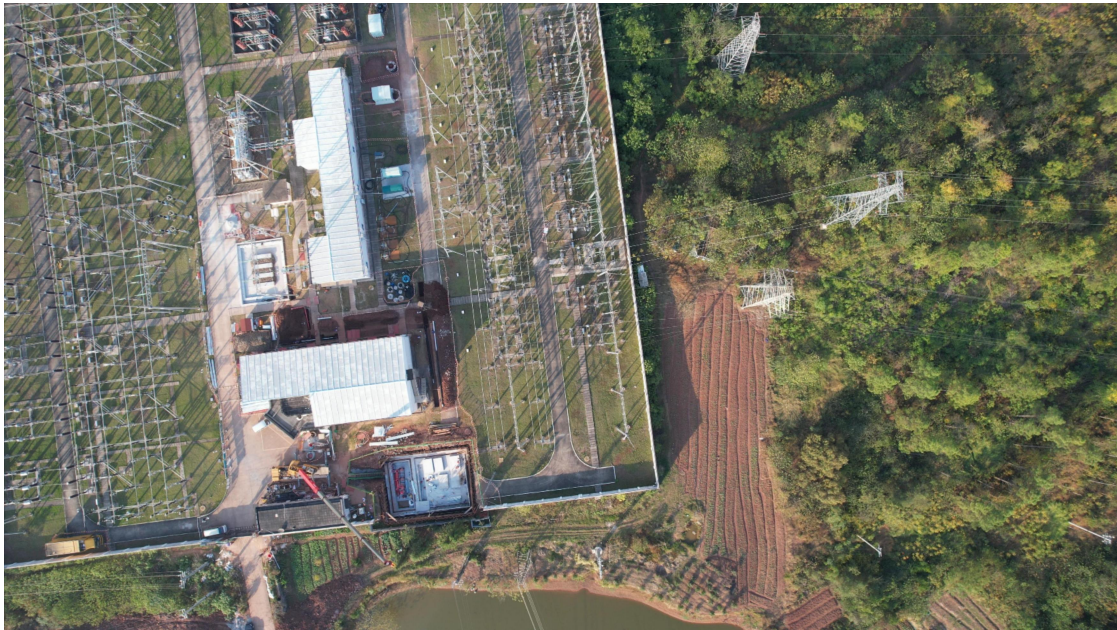
图 3-1 湛佳塘 220KV 变电站间隔扩建处生态环境质量现状
